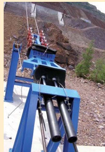
Protezione completa su strutture di prova
